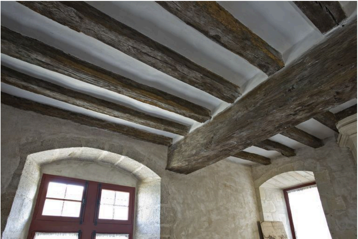
La salle basse : détail de la poutraison.
