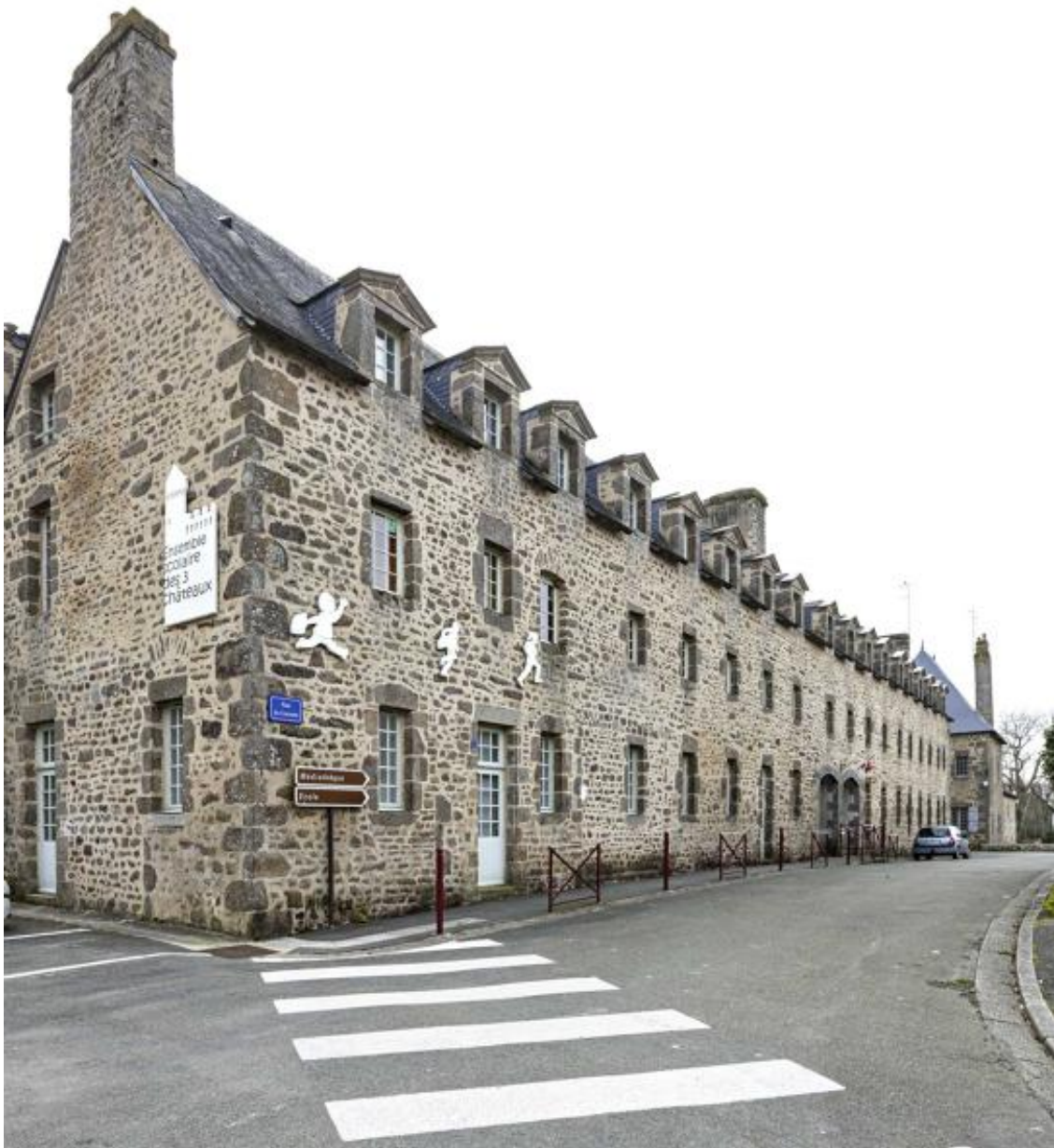
Corps de bâtiment nord du couvent de Lassay, actuellement école, vu depuis le nord-est.
