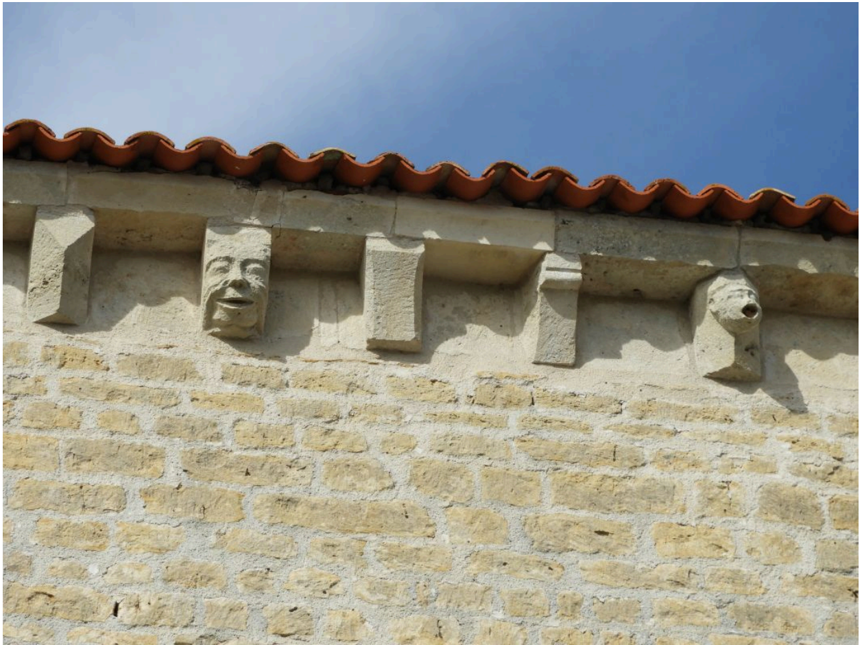
Modillons du mur sud de la nef, d'ouest en est : vue 1.
