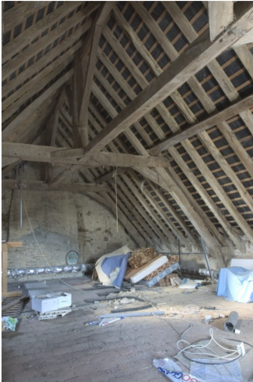
La charpente du logis vue depuis l'est.
