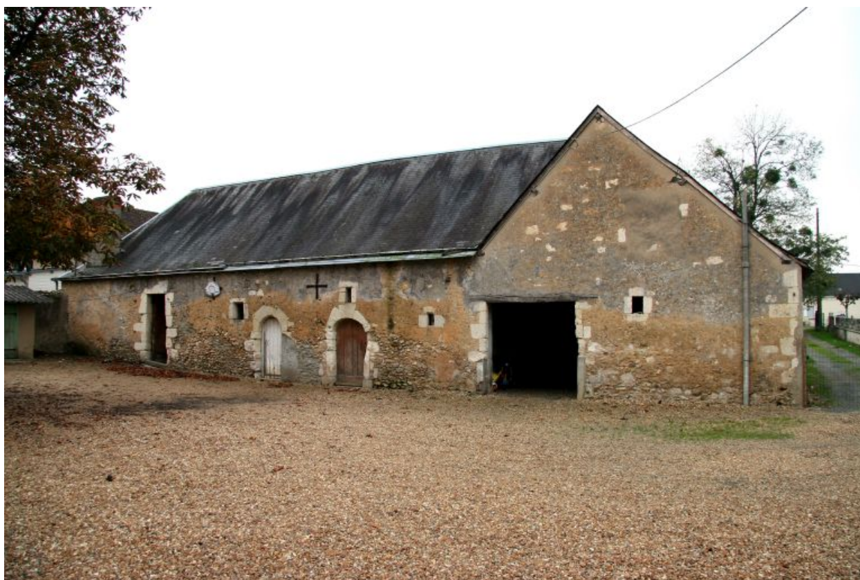
Les communs : façade antérieure sur cour.
