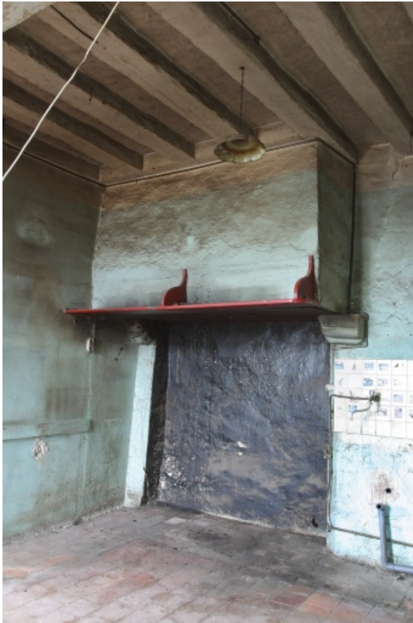
Intérieur du corps nord, premier étage, pièce ouest : la cheminée vue depuis l'ouest
