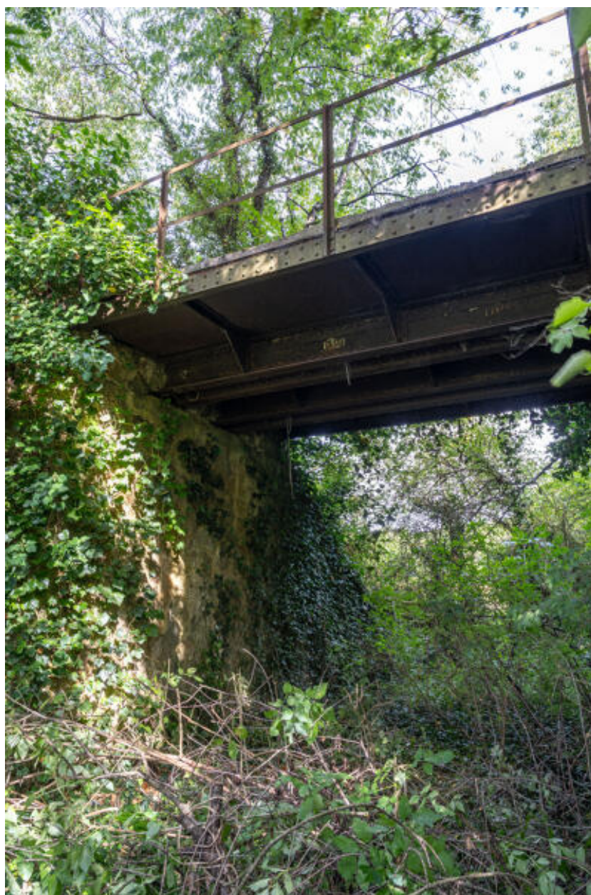
Vue en contre-bas du pont.
