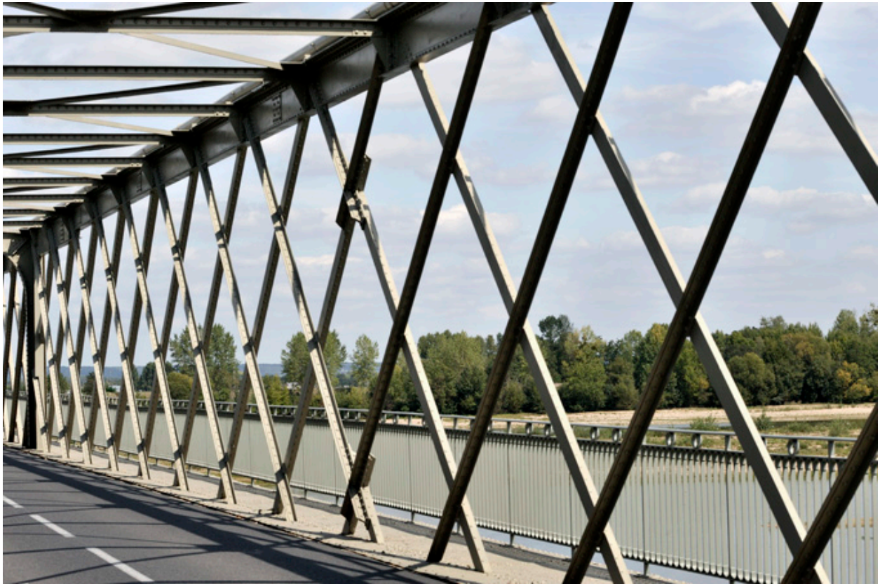
Charpente métallique (détail)
