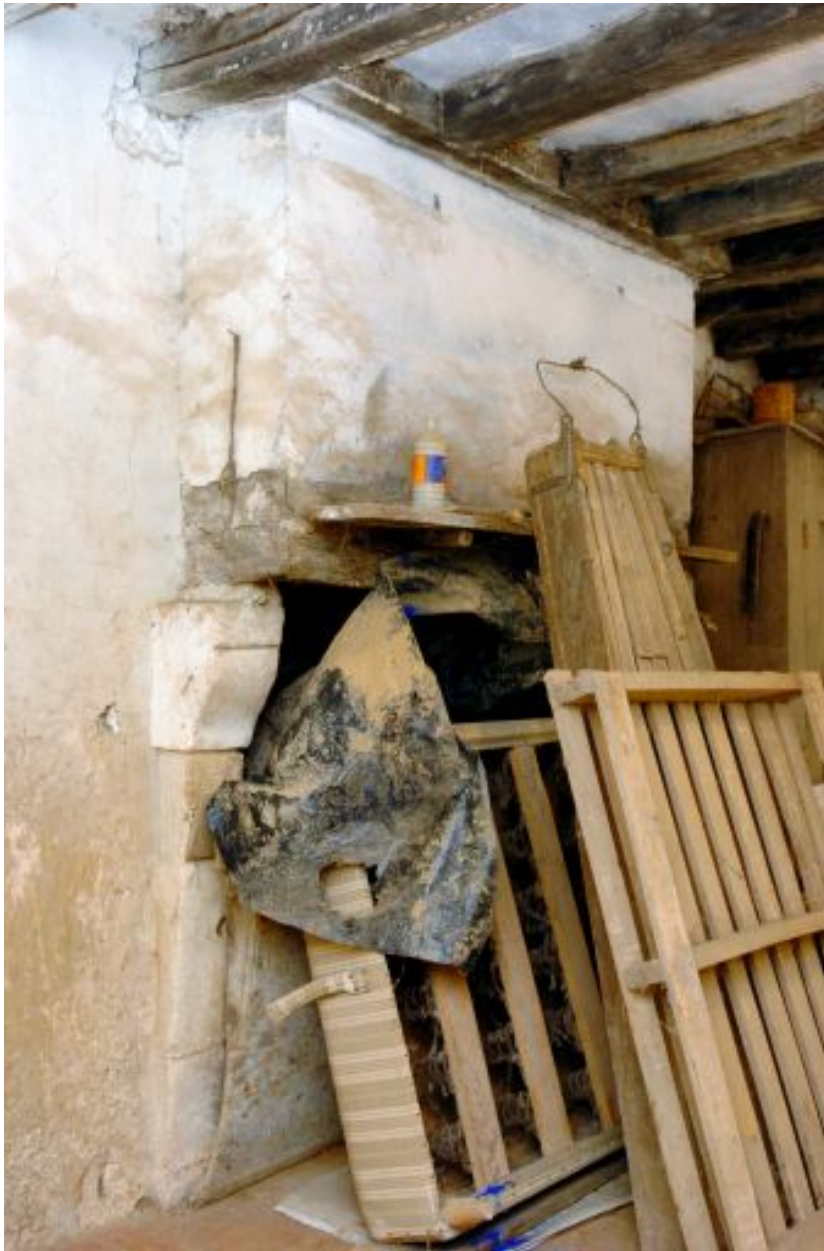
La buanderie de l'autre côté du portail : la cheminée.
