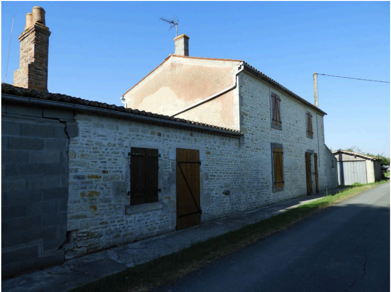
Le logis vu depuis le nord-est.
