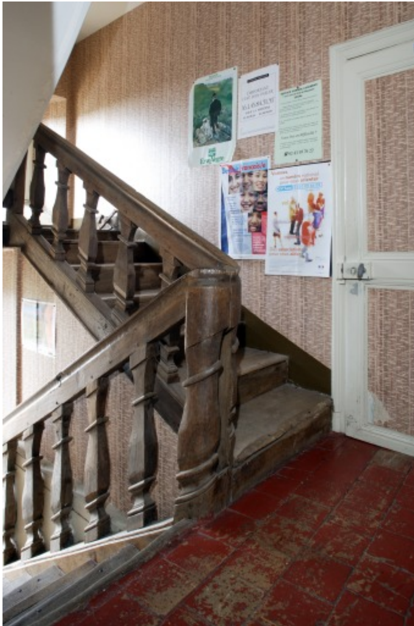
L'escalier vu depuis le palier du premier étage.
