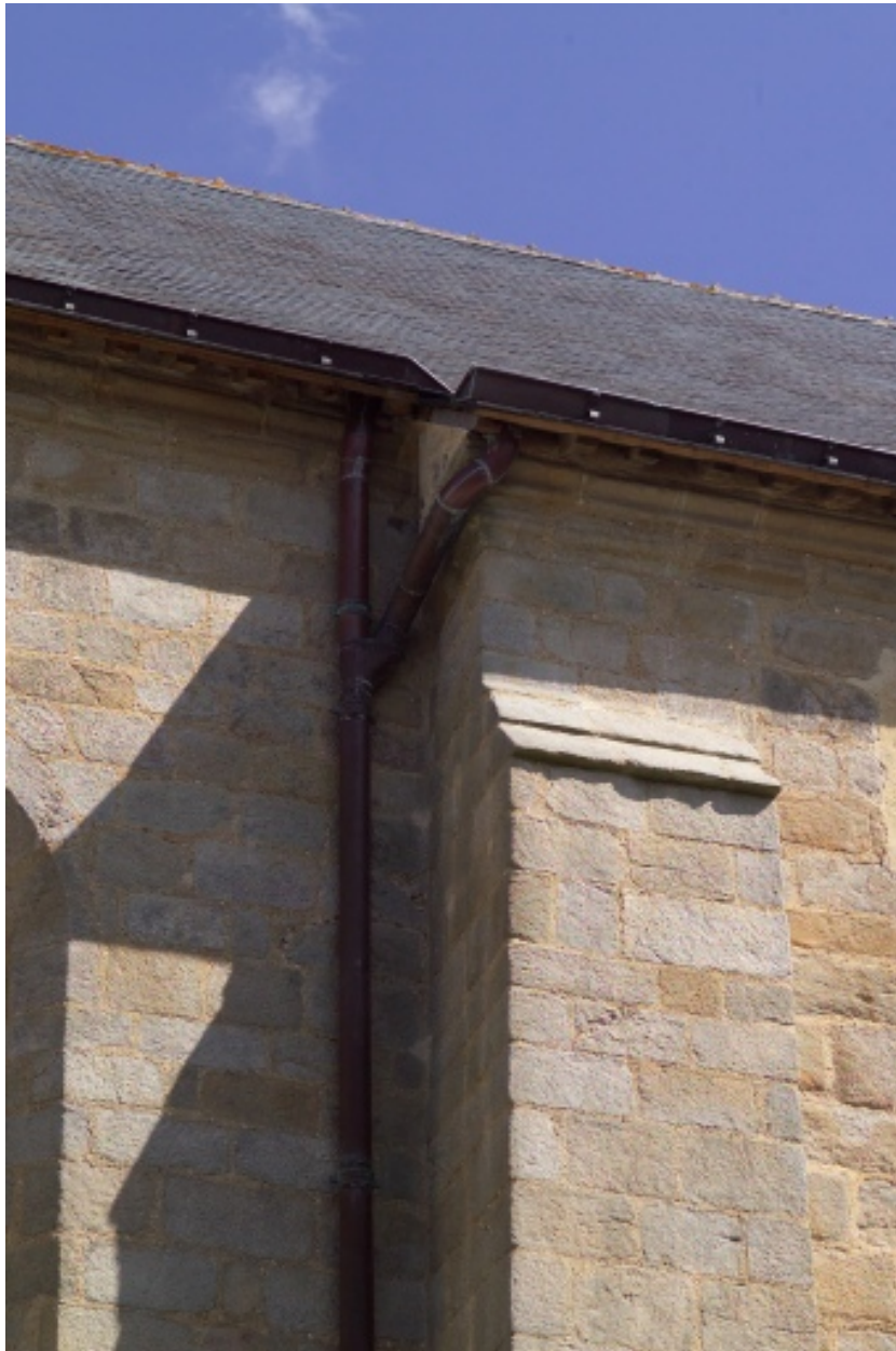
Détail du décrochement du mur sud entre la seconde travée et le portail.
