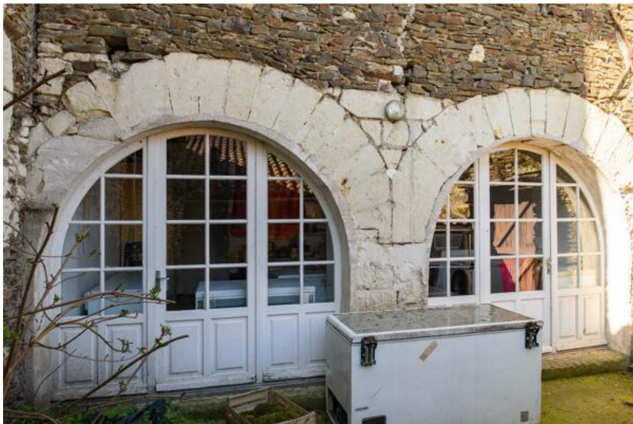
Détail des arcs sur le mur de pignon nord-est.
