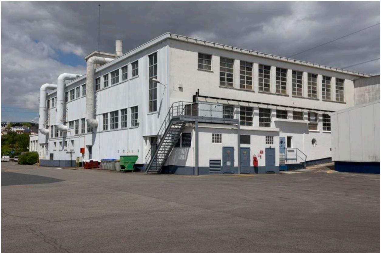
Arrière du bâtiment de fabrication et de broyage.
