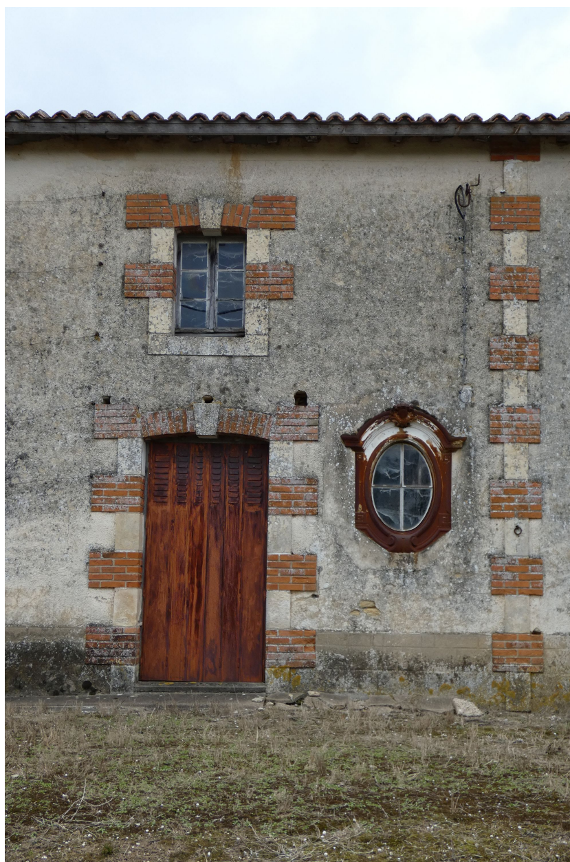
Détail de la façade et du décor de la grange-écurie : brique et pierre, baie ovale en métal.
