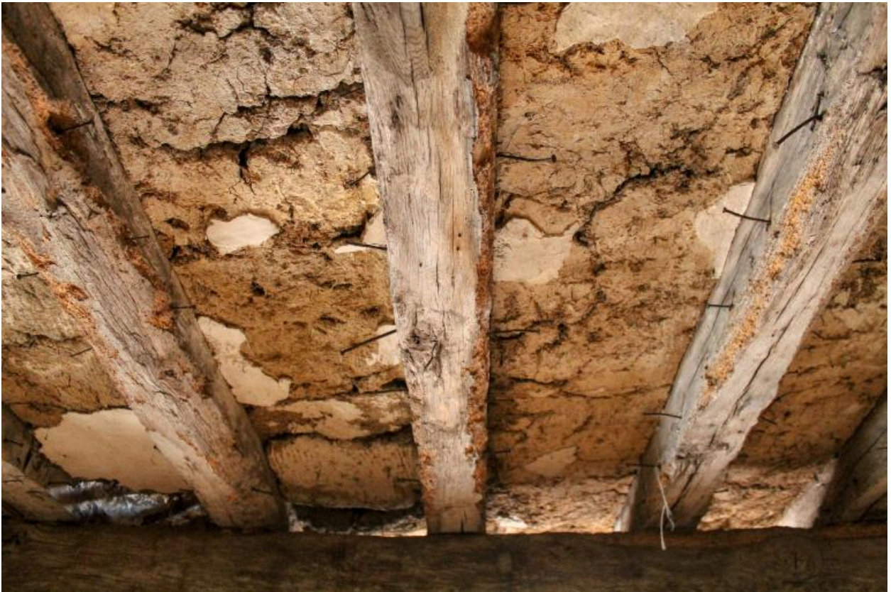
Le plafond de l'étage.
