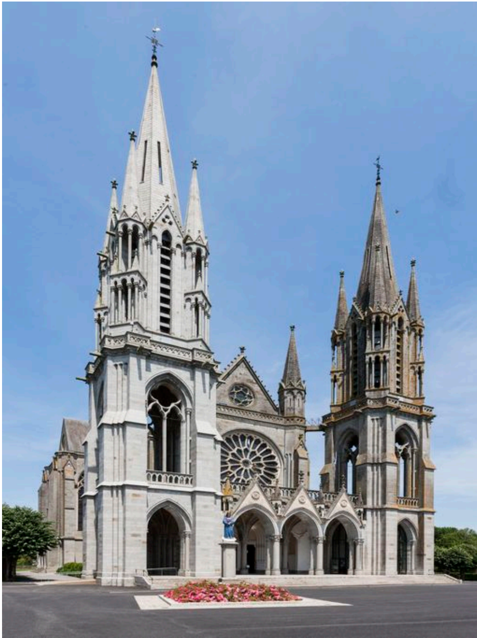
La façade principale vue depuis le sud-ouest.
