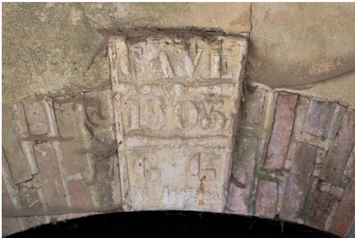
Cellier semi-enterré : date et inscription portée sur la clef de la porte.
