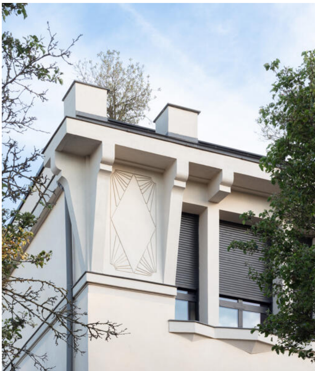
Détail des moulurations de l'immeuble Art déco place du 117e régiment d'infanterie.
