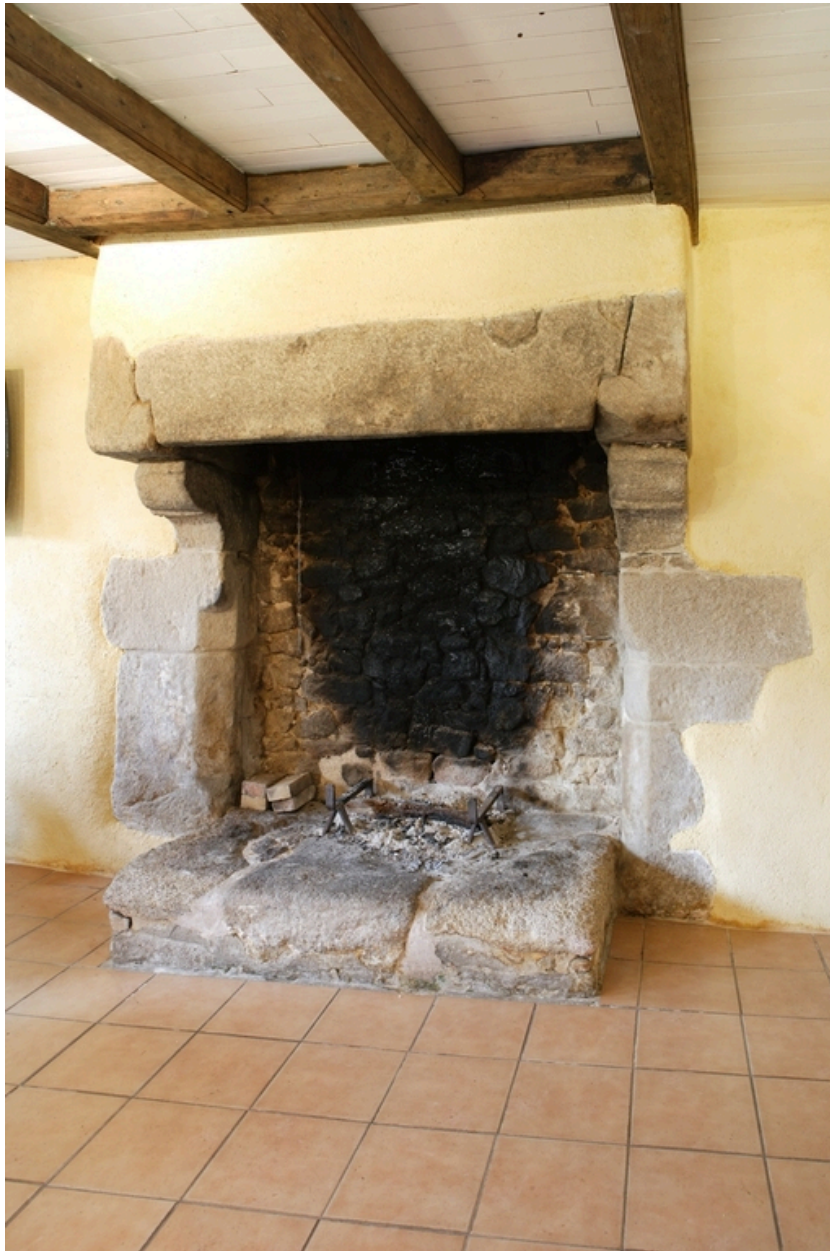
Vue de la cheminée du n° 1 impasse Prémarie.
