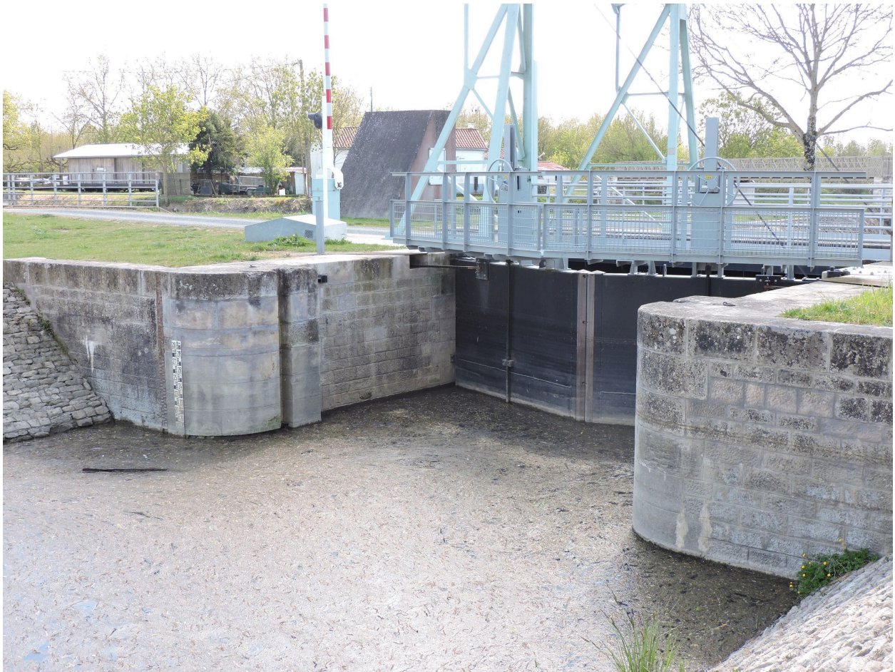
Maçonnerie en pierre de taille des culées de tête de l'écluse.
