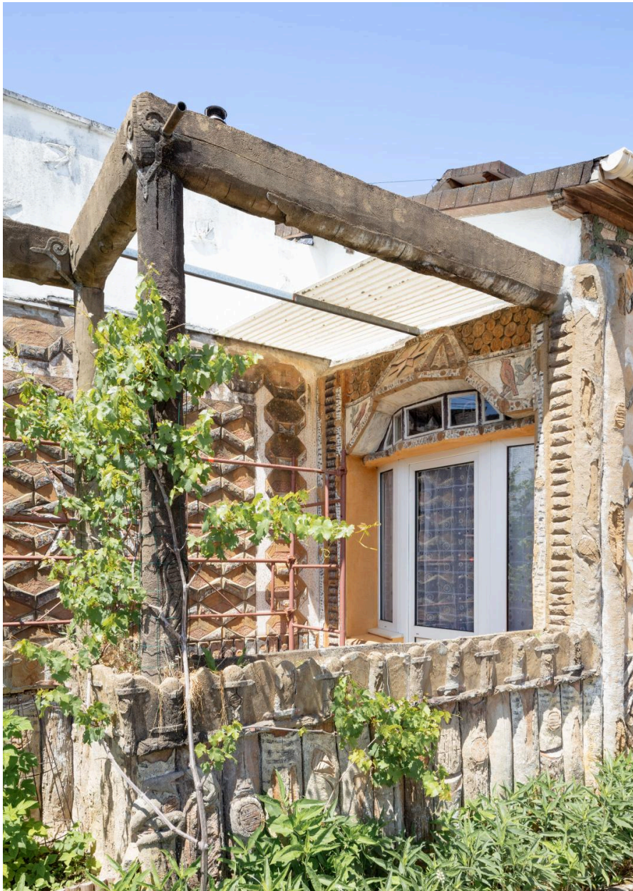
Vue de la terrasse sud.
