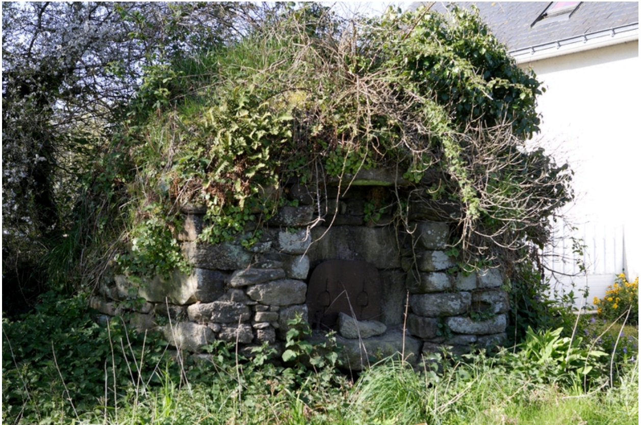
Vue du four à pain.
