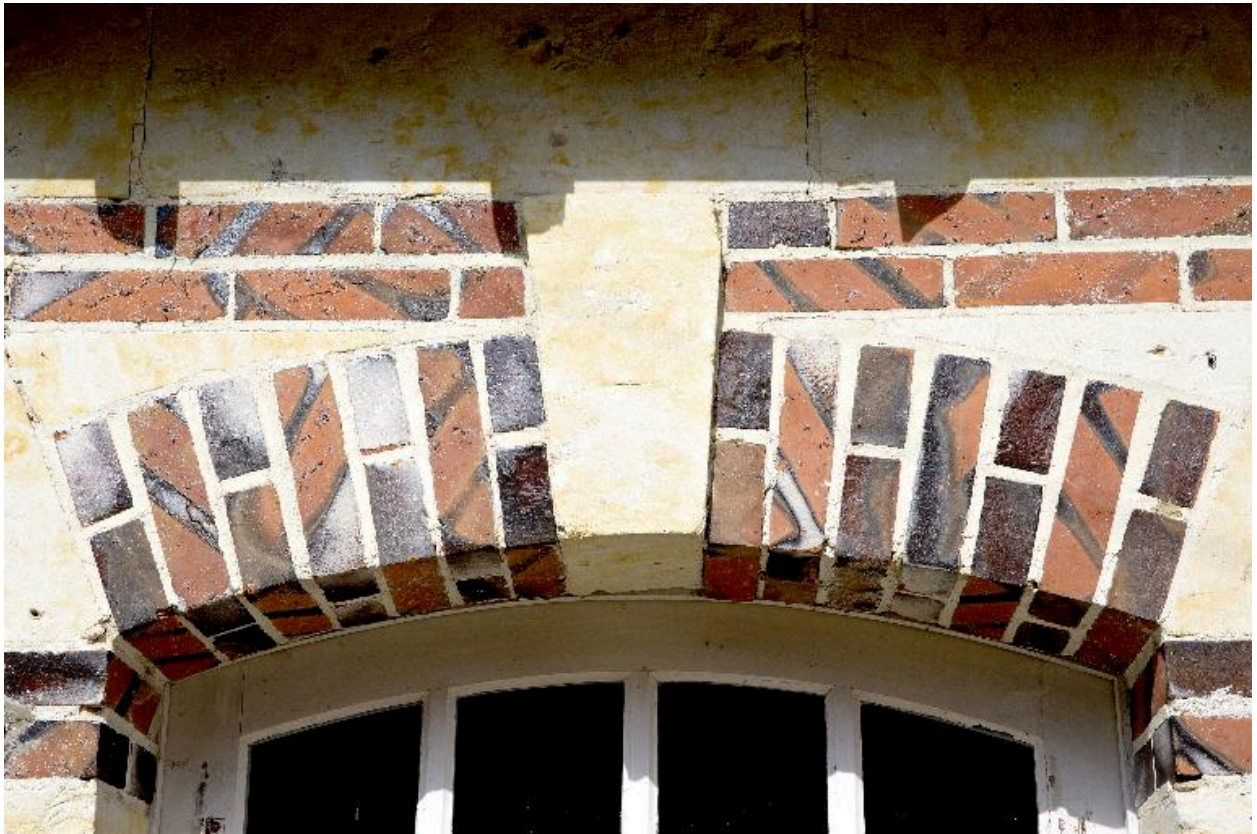
Remise : détail des matériaux du linteau de la porte (de droite).
