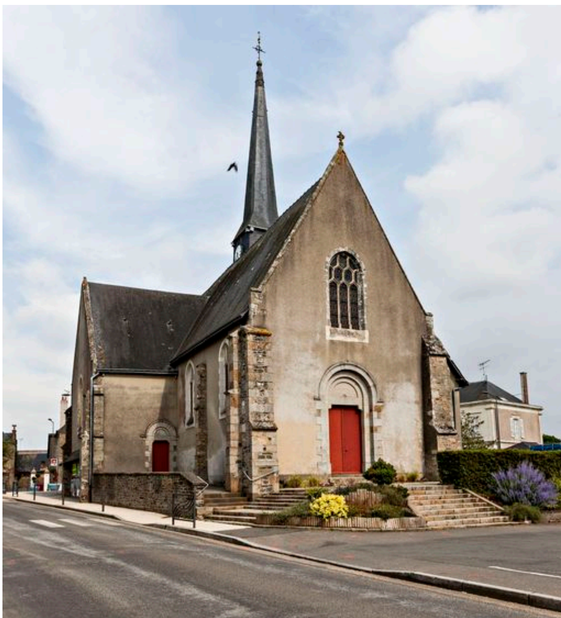
Vue d'ensemble de l'église depuis le sud-est.
