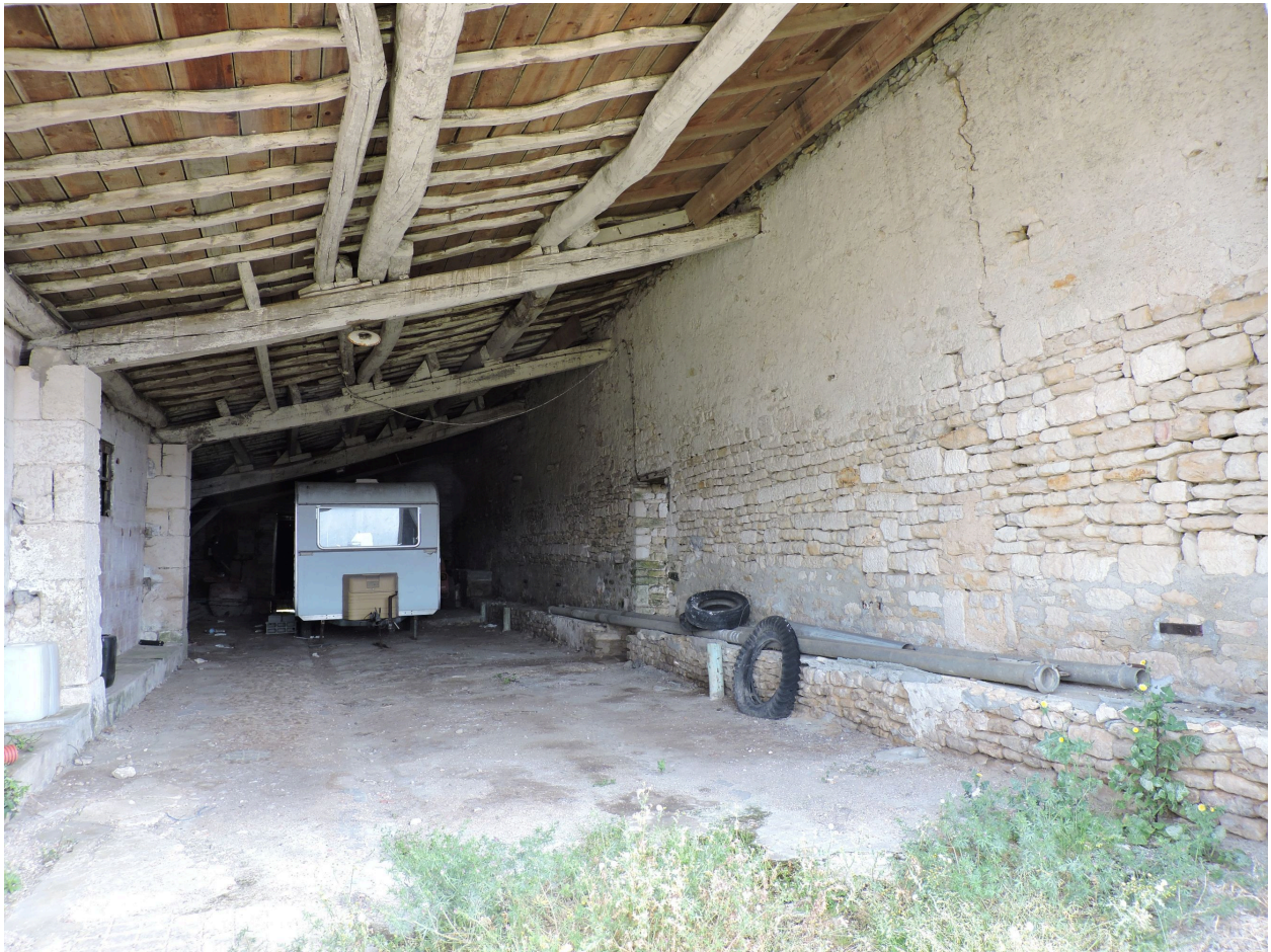
Vue intérieure de l'étable en appentis, avec vestiges de mangeoires.
