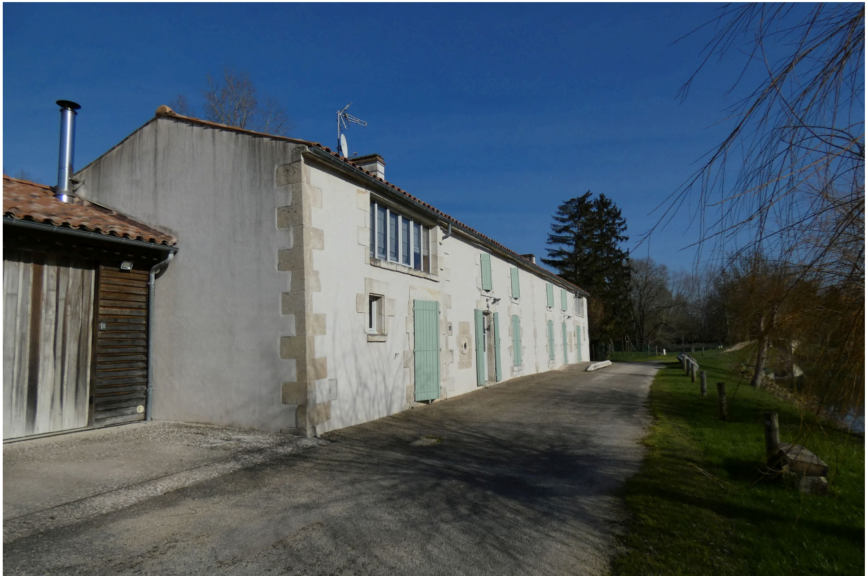
Vue depuis l'ouest.
