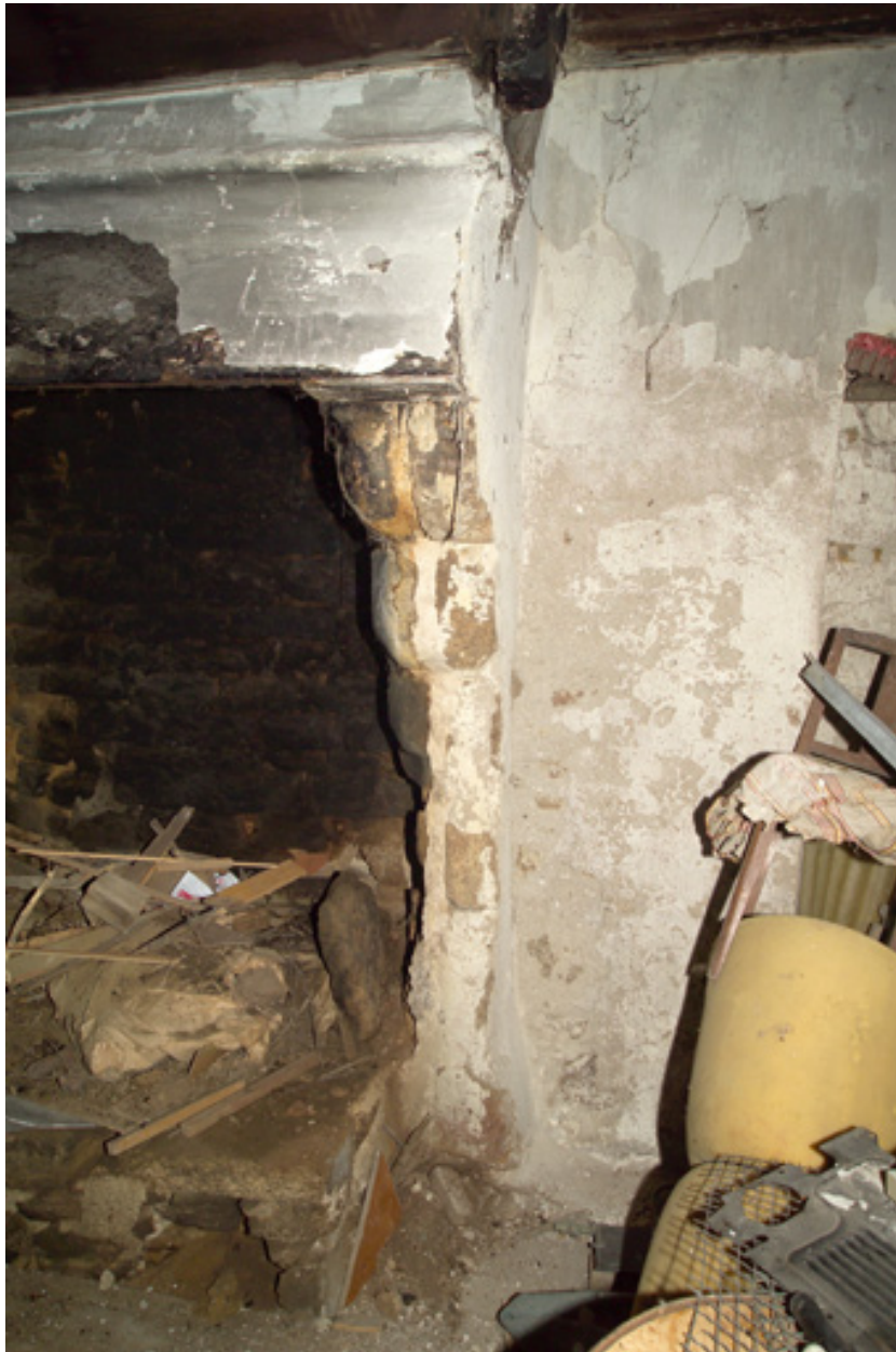
Corps principal, rez-de-chaussée, pièce orientale, cheminée, détail du montant droit.
