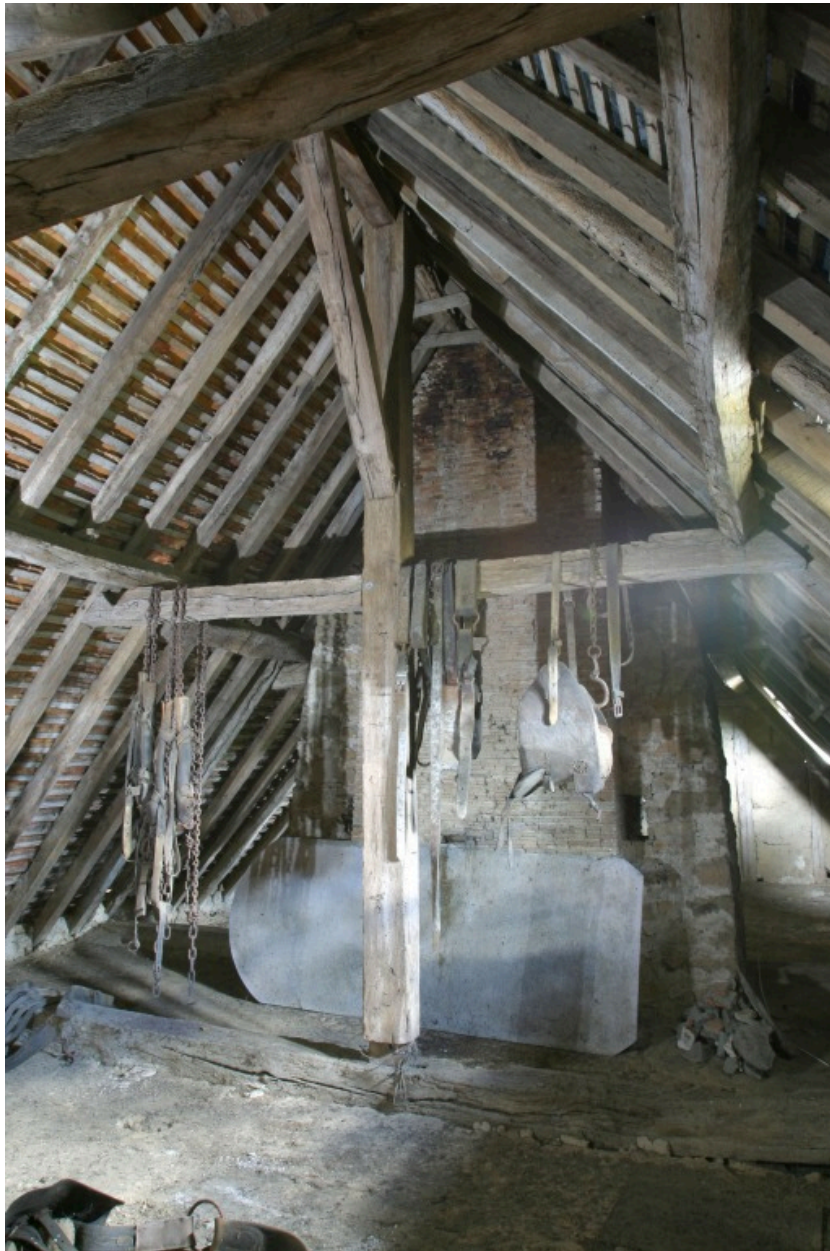
Comble du corps principal : première ferme sud.
