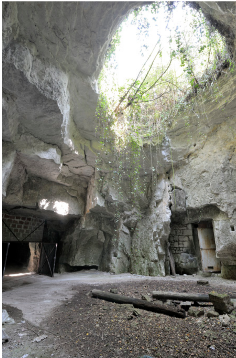
Fontis. Vue d'ensemble, avec entrée de la carrière (à gauche) et salle latérale.
