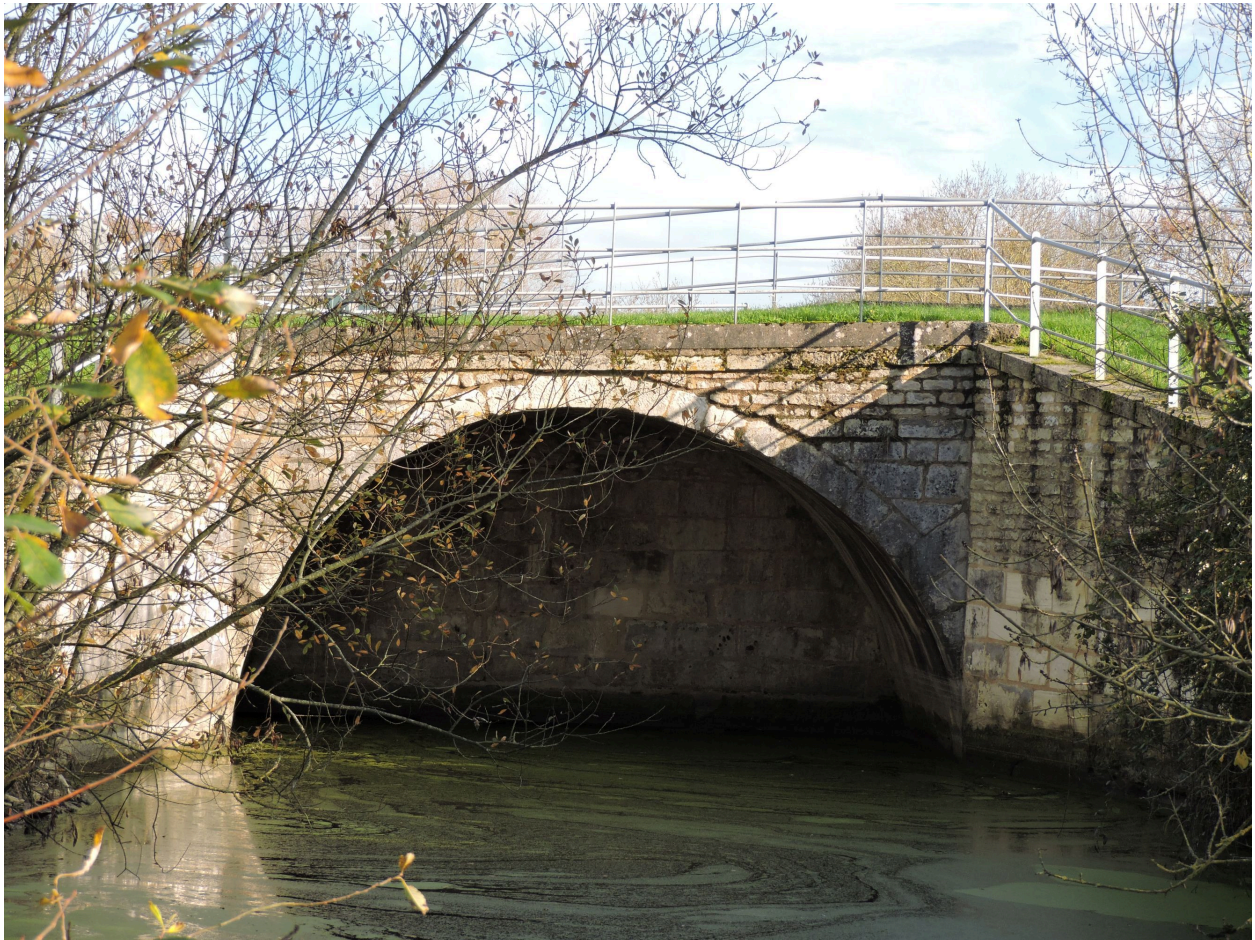
L'ancien aqueduc vu depuis l'aval, à l'ouest, avec le canal de Vix au premier plan.
