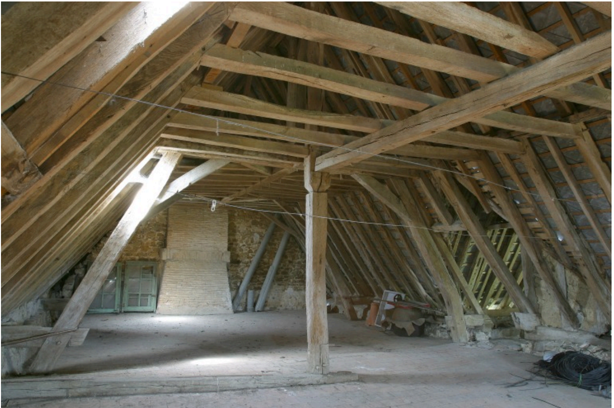
Comble. Vue d'ensemble de la charpente depuis le sud-est.
