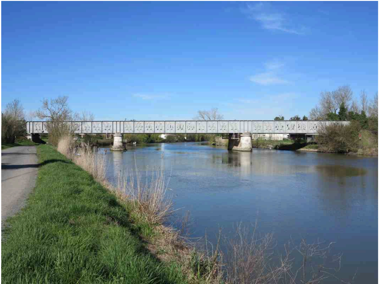
Le pont vu depuis l'amont, à l'est.
