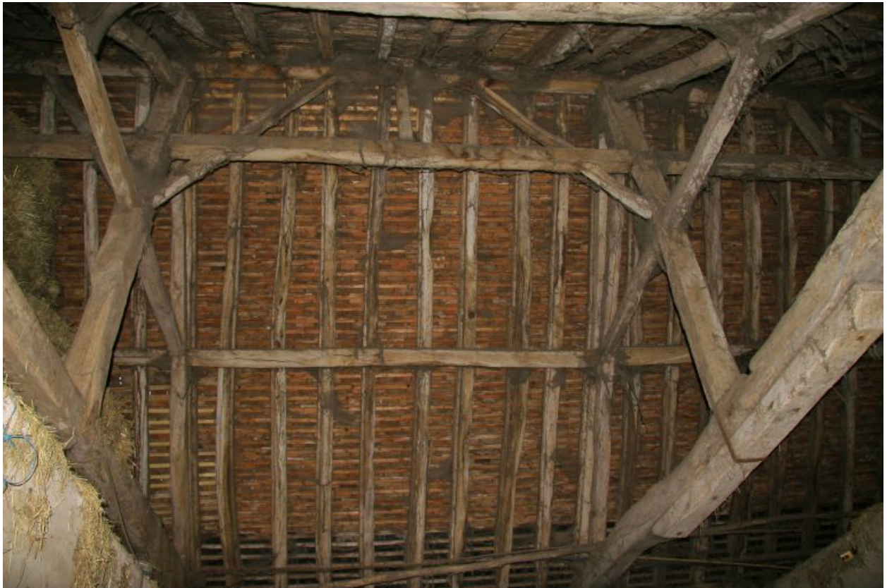
La grange-étable : charpente à pannes et sous-faîtage.
