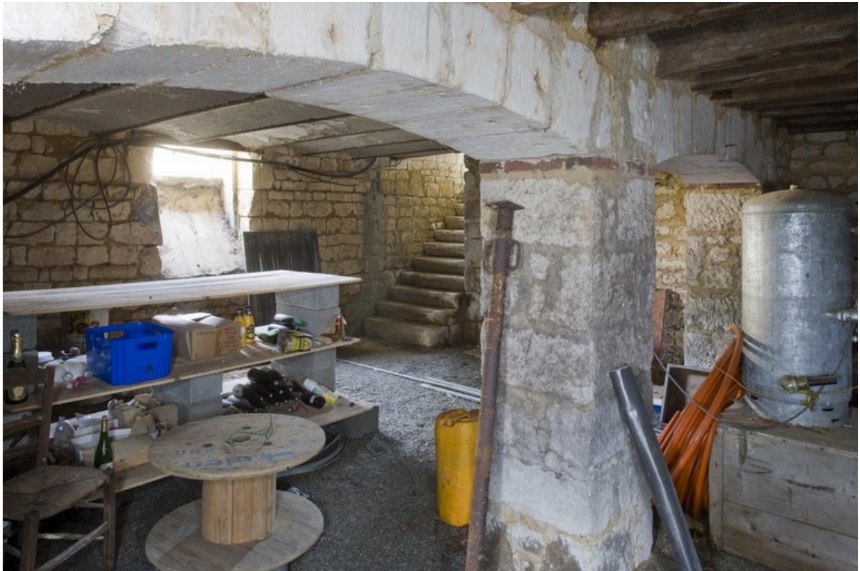
Vue du sous-sol de la maison.
