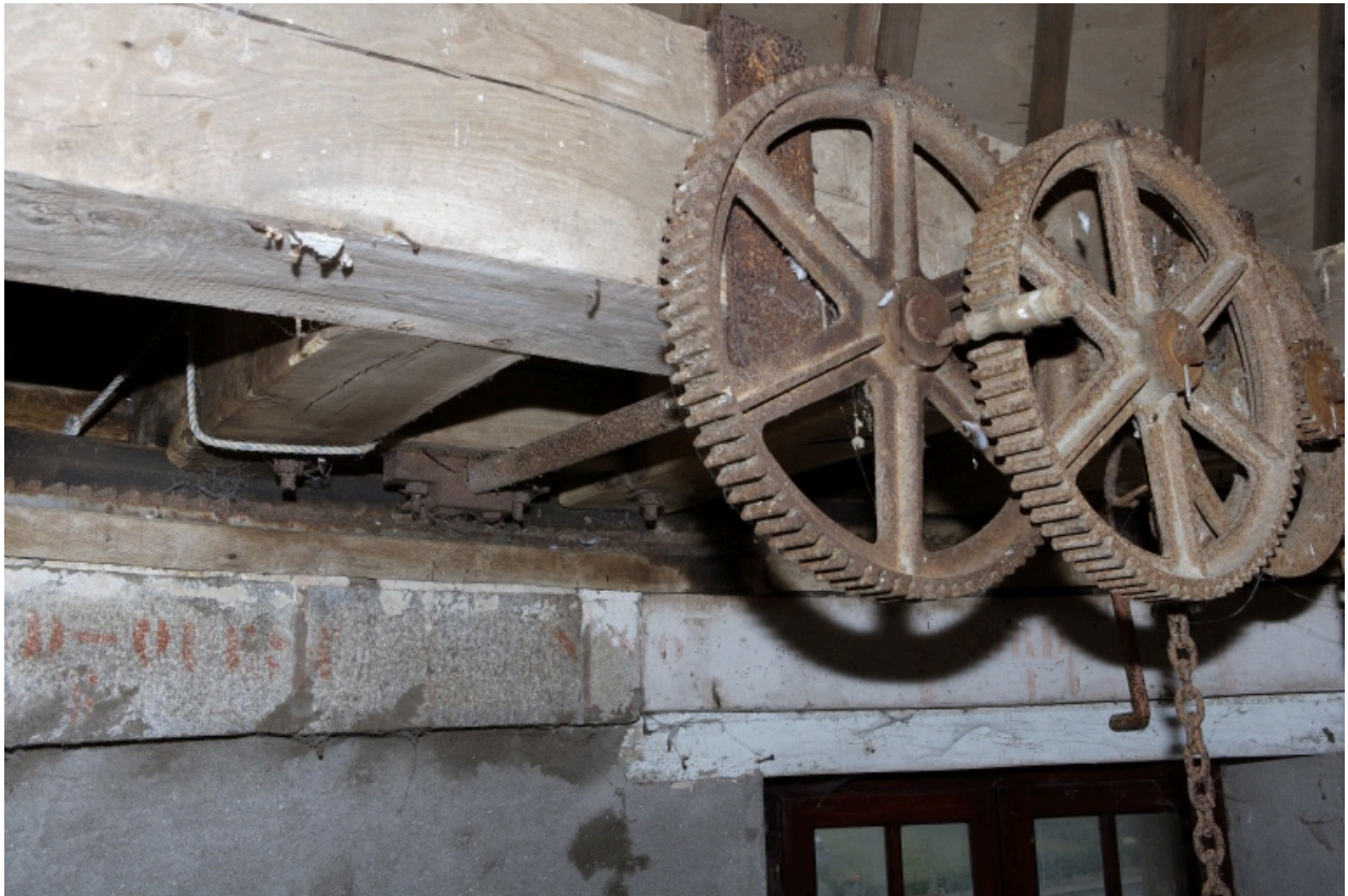
Étage de comble. Détail du treuil servant à orienter le moulin au vent, et de la crémaillère fixée sur la sablière dormante.
