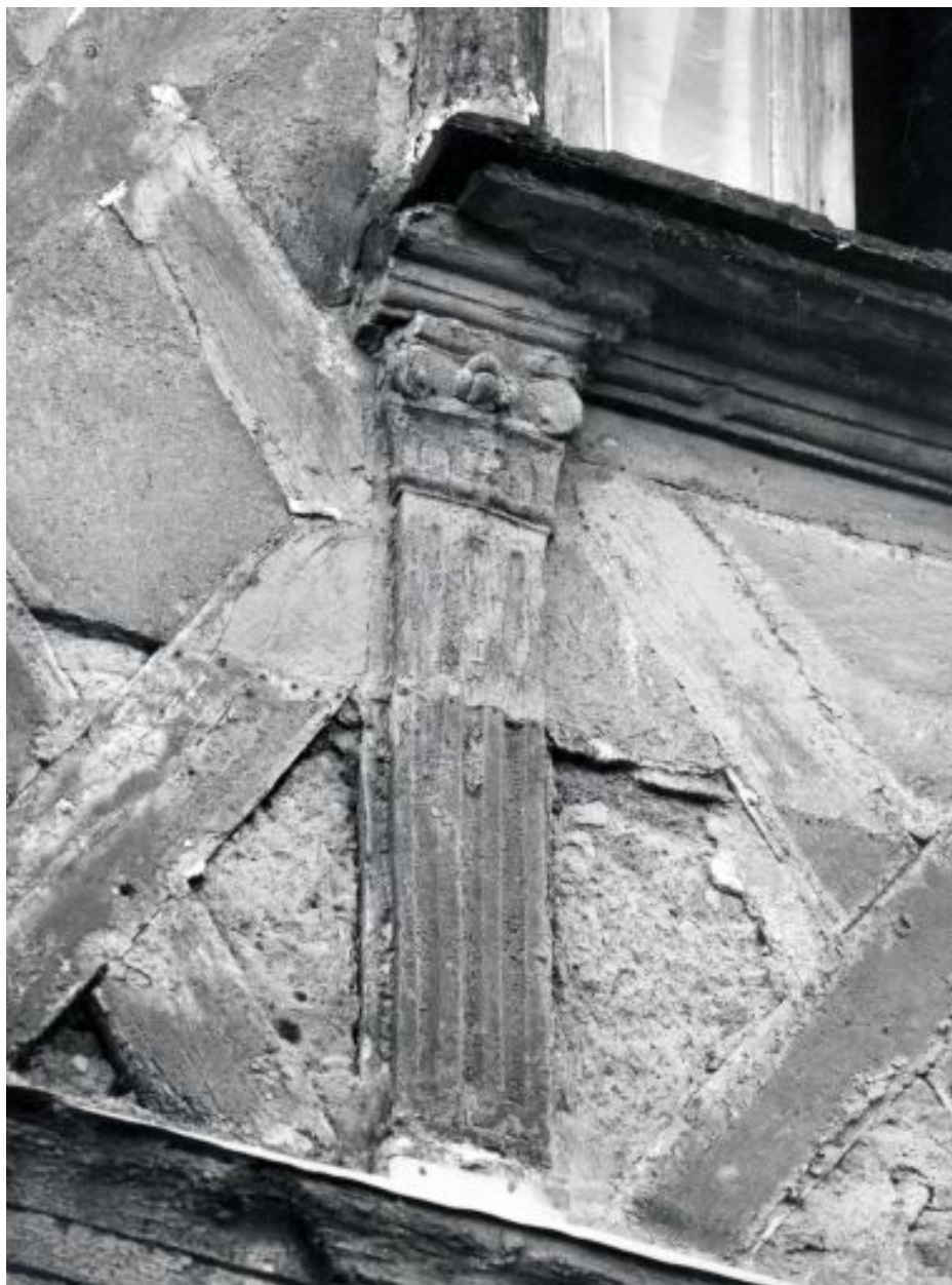
Elévation antérieure, 2e étage, fenêtre : allège, potelet gauche.
