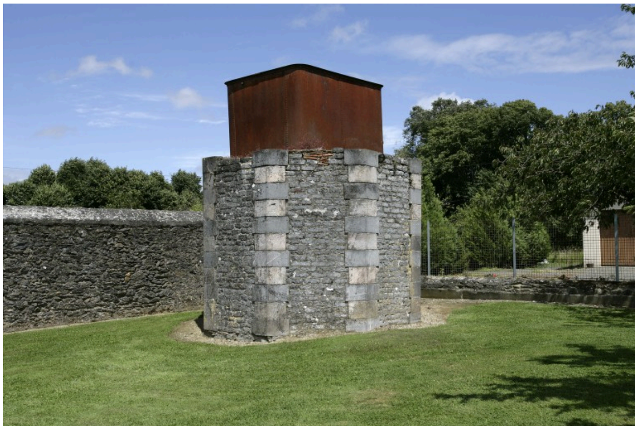
Le château d'eau.
