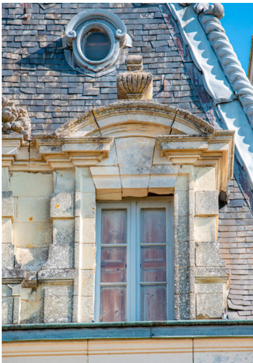
Le pavillon sud-est, détail d'une lucarne.
