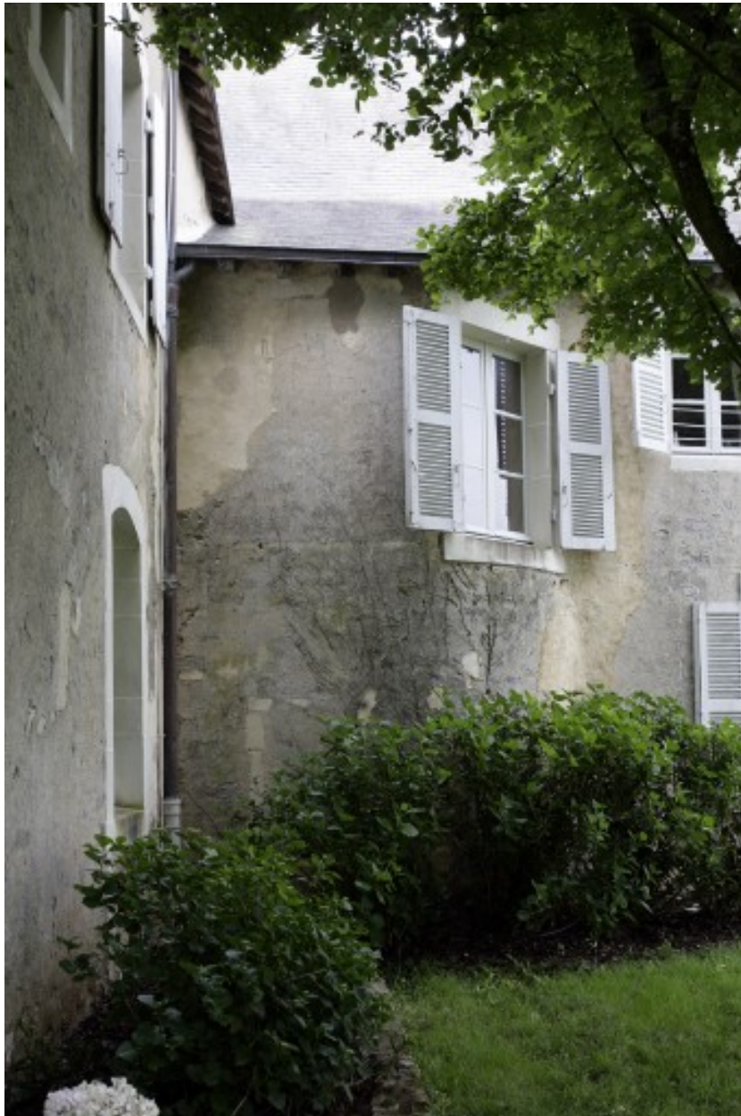
La tour d'escalier du logis vue depuis le nord.
