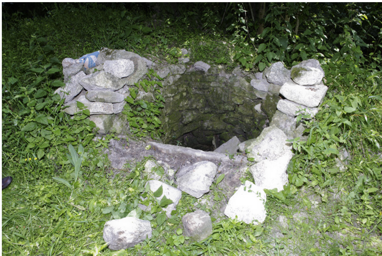
Vue du puits.
