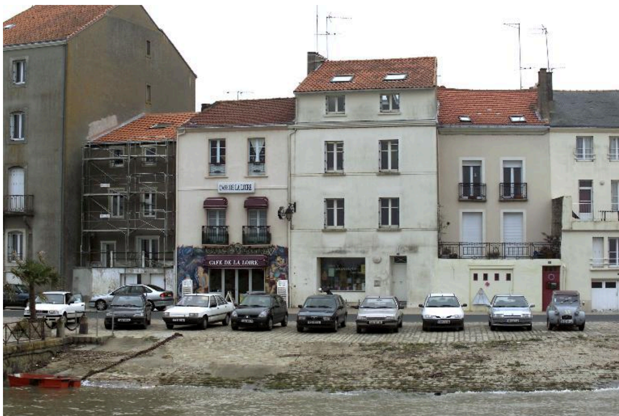
Vue du quai Boulay-Paty du n° 2 au n° 7.
