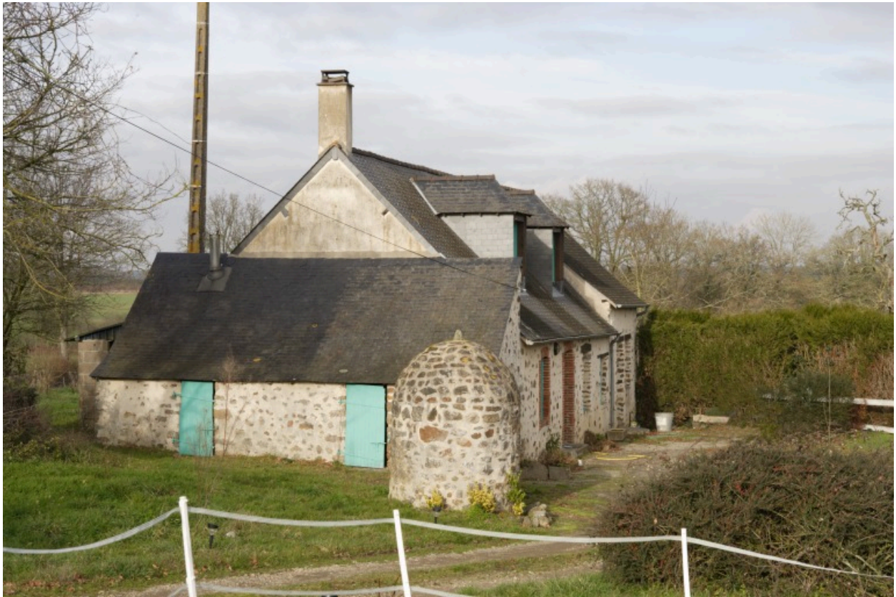
Le logis vu depuis le sud.
