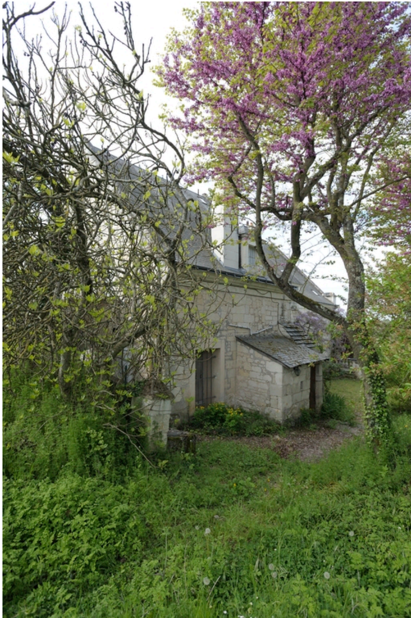
Façade nord-est, ponctuellement remaniée au XIXe siècle.
