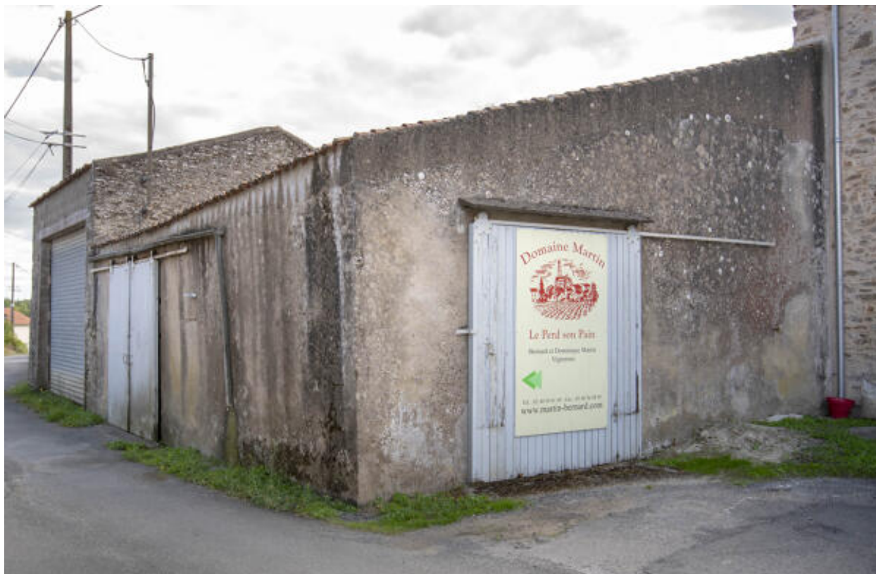
Portes sur rail au négoce Boutin, la Hautière, Saint-Fiacre-sur-Maine.
