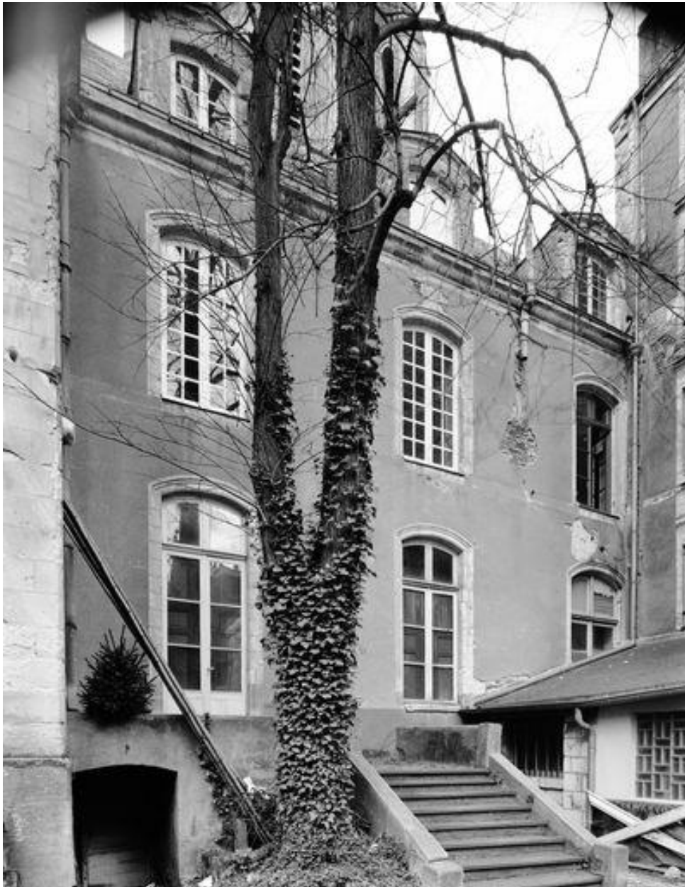
Second logis abbatial (XVIII e siècle), corps principal : élévation antérieure, sur cour.
