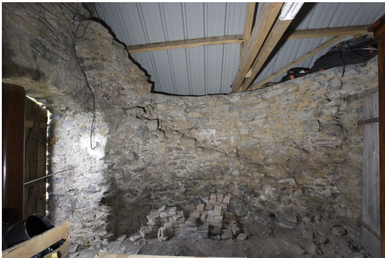
Bâtiment sud, pièce ouest : mur nord.
