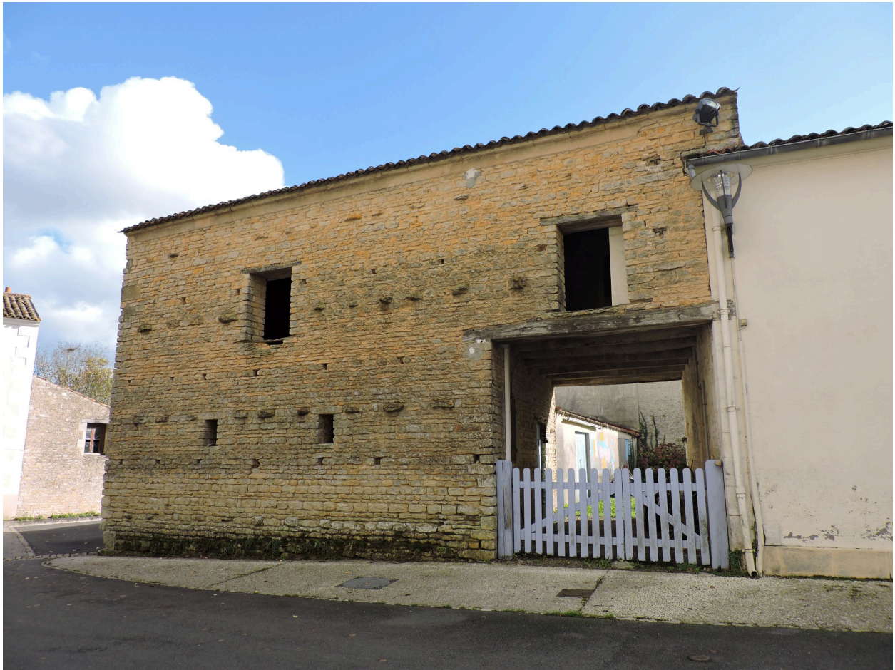
Les dépendances et le passage couvert vus depuis le nord.
