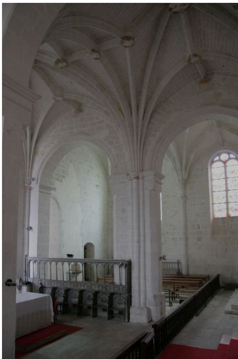
Pilier entre le chœur et la chapelle sud.
