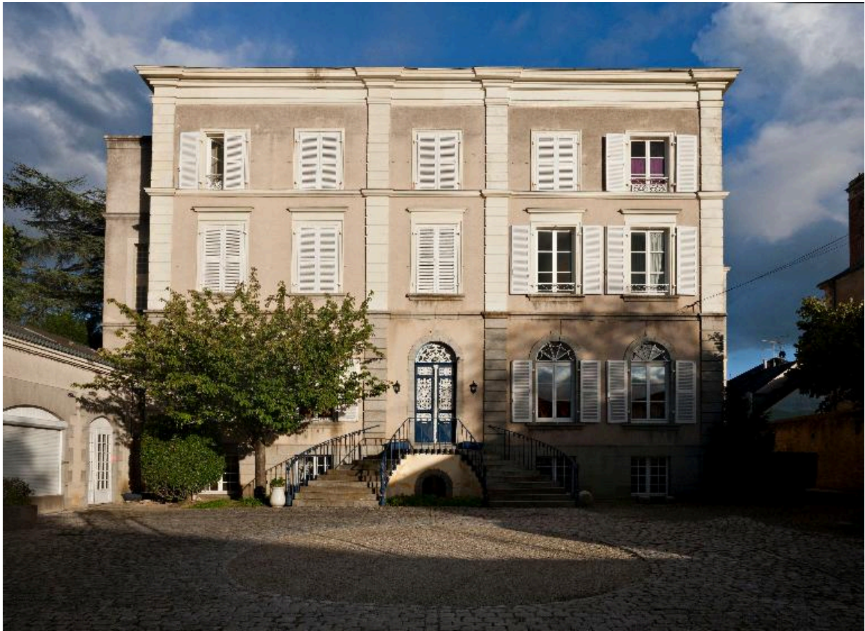
Élévation antérieure : vue d'ensemble depuis la cour.
